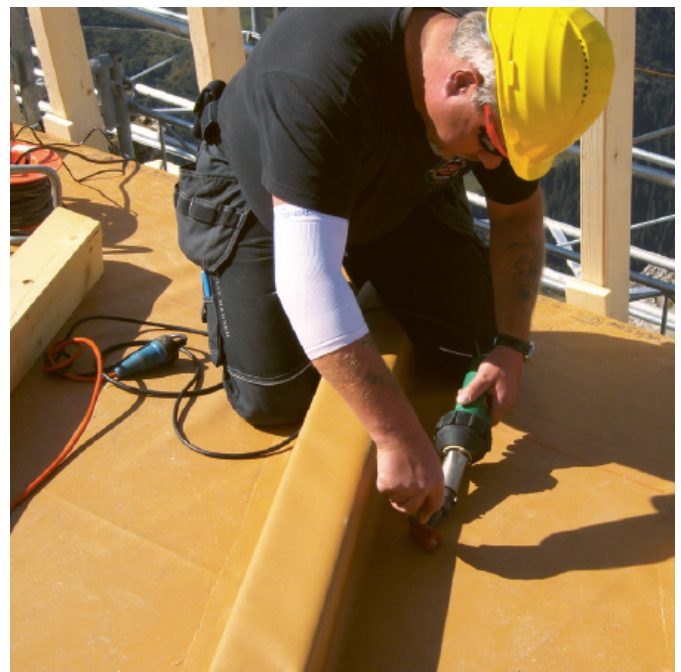
Abb. 3: Komplettes Einschweissen der Konterlatte.
